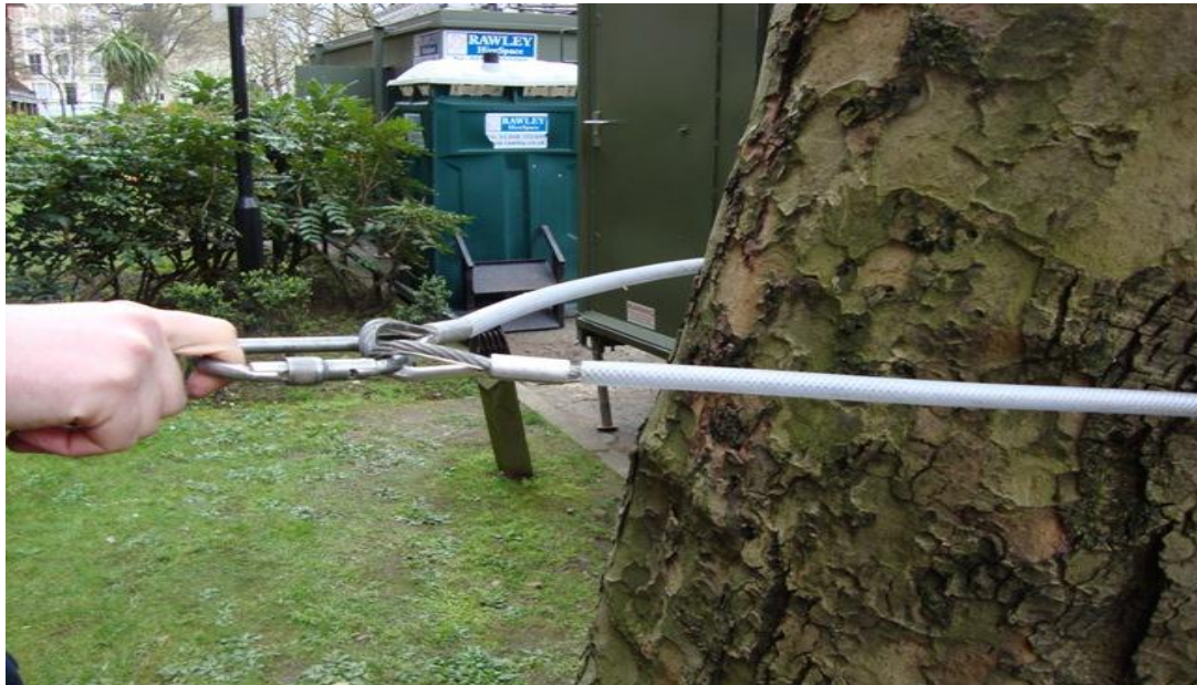
Foto 1: Streichriemen als Hauptverankerung aufgebaut. Insgesamt wurden vier davon genutzt, um die vier Seile zu verankern.
